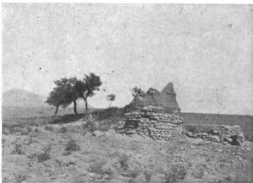
Фиг. 7. Персидская мельница под землей. Вода выводится кяризом.
